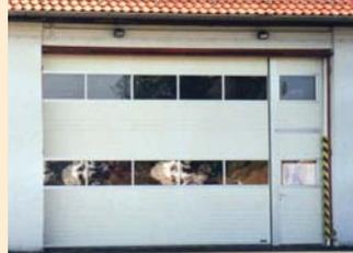
**Schlupftüre:** Türrahmen aus stabilen, stranggepressten Aluminium-Profilen, eloxiert im Naturton E6 EV1. Zur serienmäßigen Ausstattung gehören ein Einsteckschloss (PZ vorgerichtet), Rosetten, Drückergarnitur, umlaufende Dichtungen und ein hydraulischer Gleitschienen-Türschließer.
