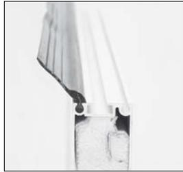
Sturzabdichtungsgummi an der obersten Section
